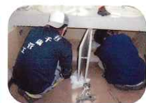
4Fトイレ 自動水栓手洗いへ
